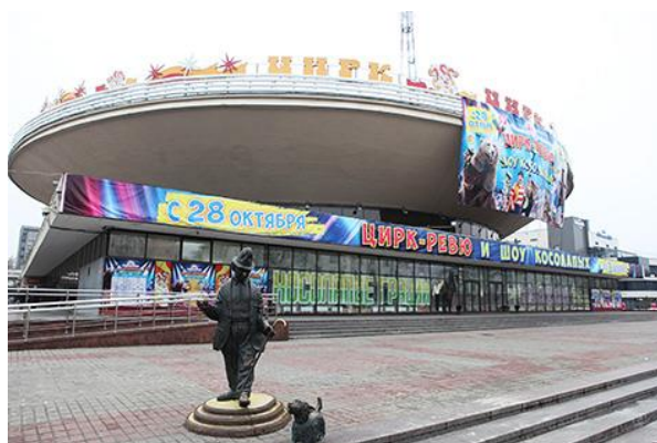
(il circo di Gomel, in Bielorussia)
